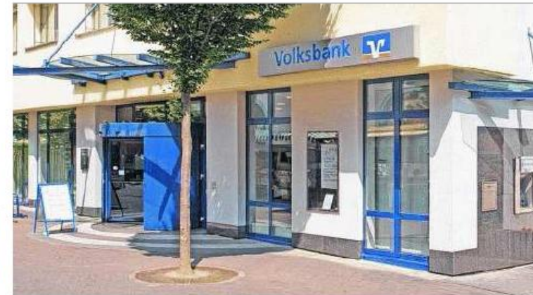
Das Volksbank-Servicezentrum in Bad Nauheim.
